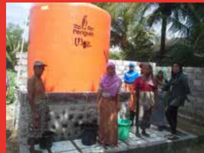
De geplaatste en aangesloten watertank in IJlobalit
